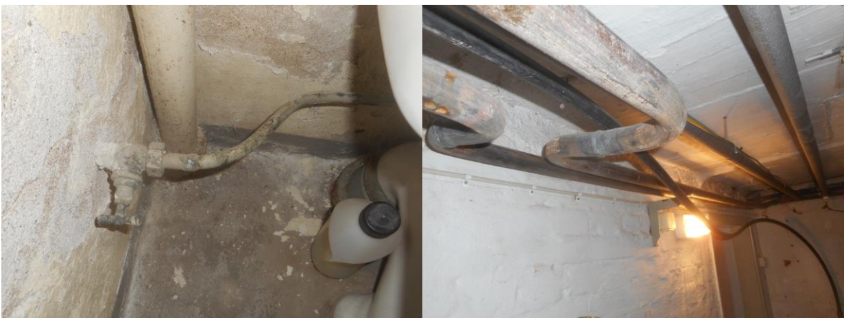
Kuva 62, osittain käytössä oli edelleen todella vanhoja käyttövesijohtoja
