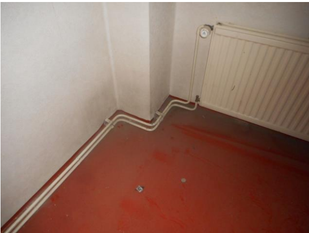
Kuva 41, pohjakerroksessa sisäpuolelta eristettyjä seiniä ja muovimatot maanvastaisissa lattioissa
