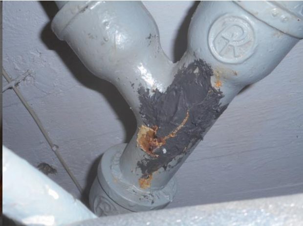
Kuva 65, Viemäririkkoa paikattu
