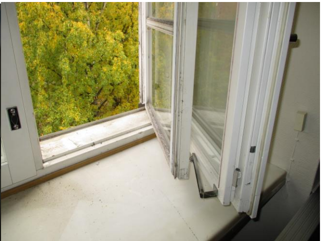
Kuva 24, 1. kerroksen ikkunat ovat julkisivulinjasta reilusti sisempänä, sääräsitus on ollut kevyempää ja ulkopuitteet asteen paremmassa kunnossa
