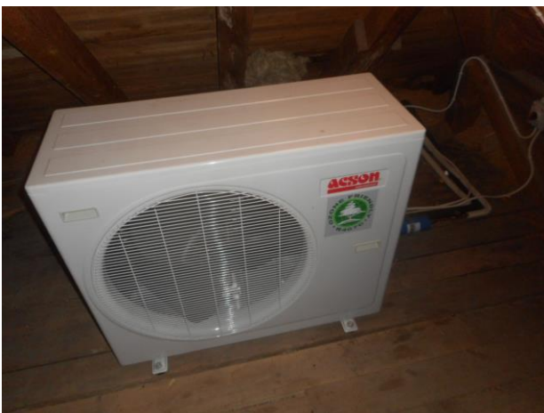
Kuvat 72-73, Ilmalämpöpumppujen ulkoyksiköitä on sijoitettu sisätiloihin ja ullakolle
