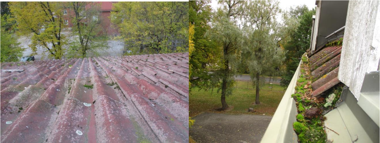
Kuvat 30-31, vesikatolla ja etenkin räystäskouruissa sammalta
