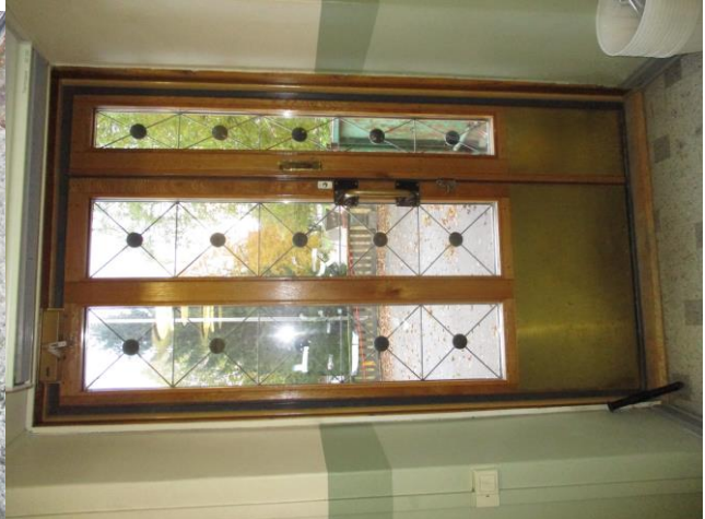
Kuva 27-28, Ulko-ovi oli uusittu n.15 vuotta sitten, tammiverhoukset olivat vanhemmat
