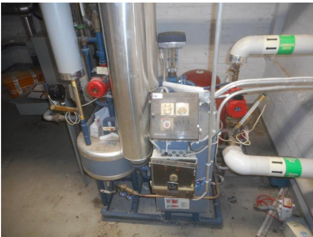
Kuva 56, Lämmönvaihdin
