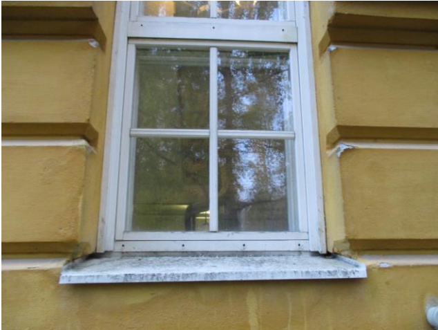
Kuva 24, 1. kerroksen ikkunat ovat julkisivulinjasta reilusti sisempänä, sääräsitus on ollut kevyempää ja ulkopuitteet asteen paremmassa kunnossa
