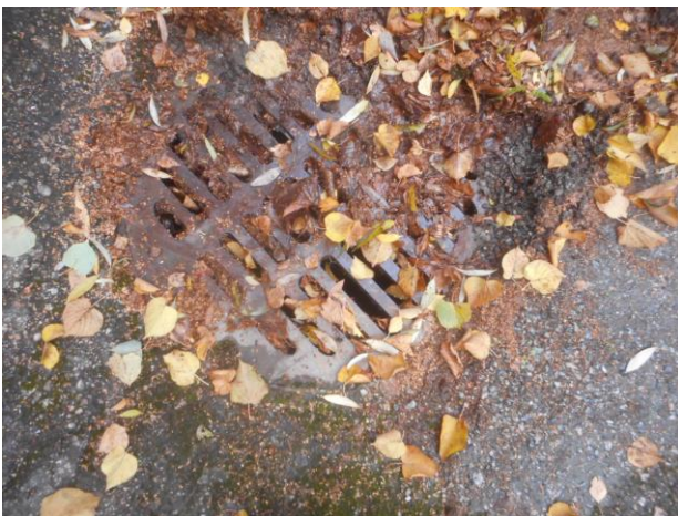
Kuva 9, pintavesikaivojen toiminta heikkoa
