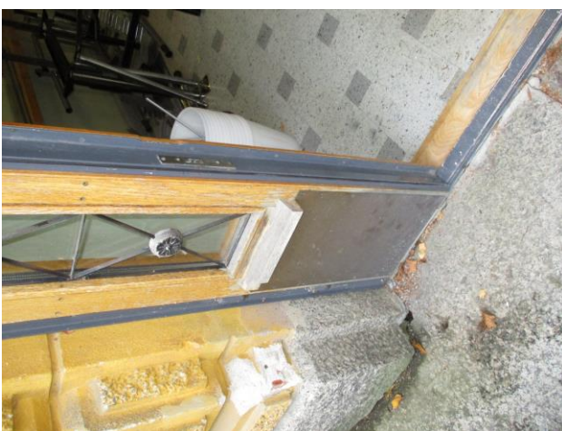
Kuva 27-28, Ulko-ovi oli uusittu n.15 vuotta sitten, tammiverhoukset olivat vanhemmat
