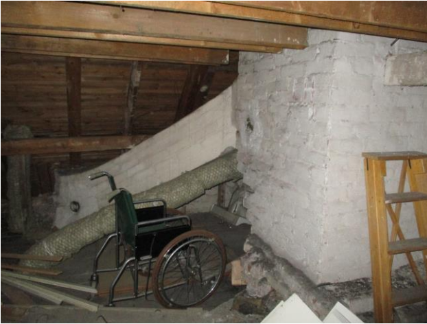
Kuvat 32-34, yleiskuvia yläpohjasta/ullakolta
