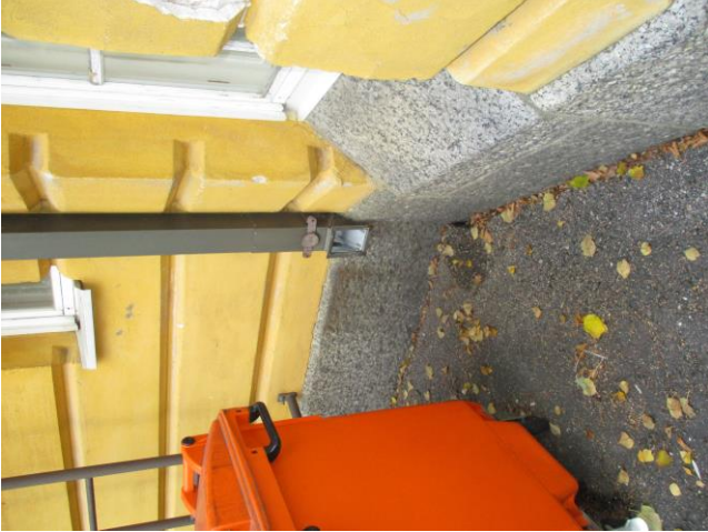
Kuva 10, Syöksytörville veden valuvat maahan, valuva vesi roiskuu sokkelipinnalle
