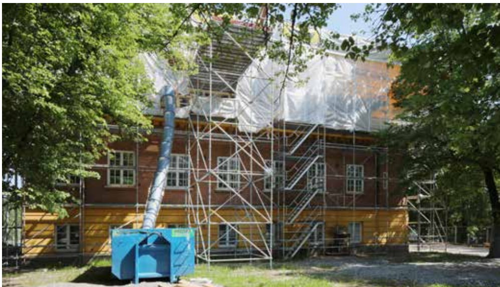
← Pääkonttori rakennustelineiden alla kesällä 2020.
