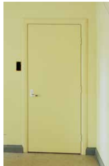
↑ Nykyaikainen laa- kaovi on peräisin viime vuosikym- menien muutos- töistä.
