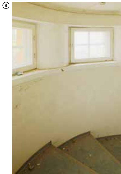
↑ Kellariin johtava porras on myöhempi muutos. Pienet ikkunat ovat alkuperäinen ratkaisu.
