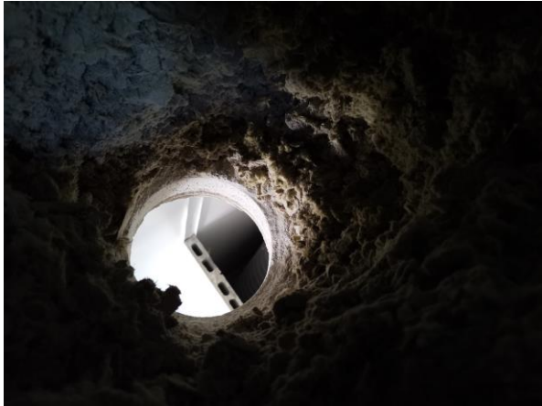
Kuva alalaattapalkiston alalaattaan poratusta läpimenoireiästä, reiästä näkyy 4.kerroksen huonetila
