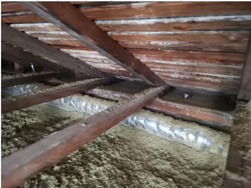
Kuva kattoristikoista ja parrusta, joka on betonivalun päällä
