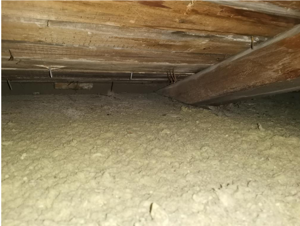
Kuva kattoristikon alapaarteesta, jonka viistetty pää on osittain rapatun räystäään sisässä
