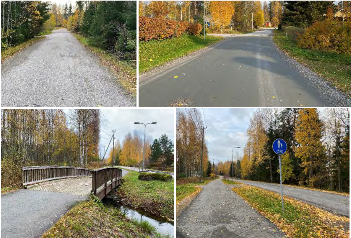
Kuva 26. Suunnittelualueen rakentunutta katuverkko. Osa pienemmistä kaduista ovat sorapintaisia kaapeita katuja ja osa asfaltoituja. Pääteiden varteen on toteutettu kevyen liikenteen väylä ja Myllypuron yli johtaa erillinen kevyen liikenteen puinen silta (kuva vasemmalla alhaalla).
