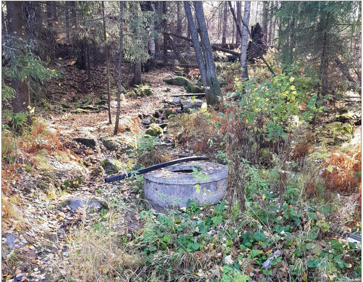
Kuva 2. Erkon lähde- ja purolehto. Lähteen suojaksi on asennettu betonirengas.
