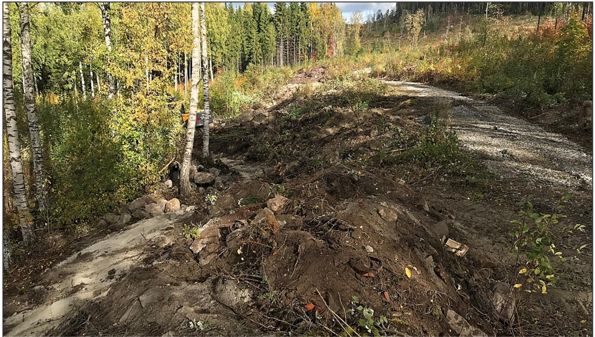
Kuva 2. Alueen 1 kunnostusvaihe, havaittua pilaantunutta maa-ainesta läjitetään aumaksi.
