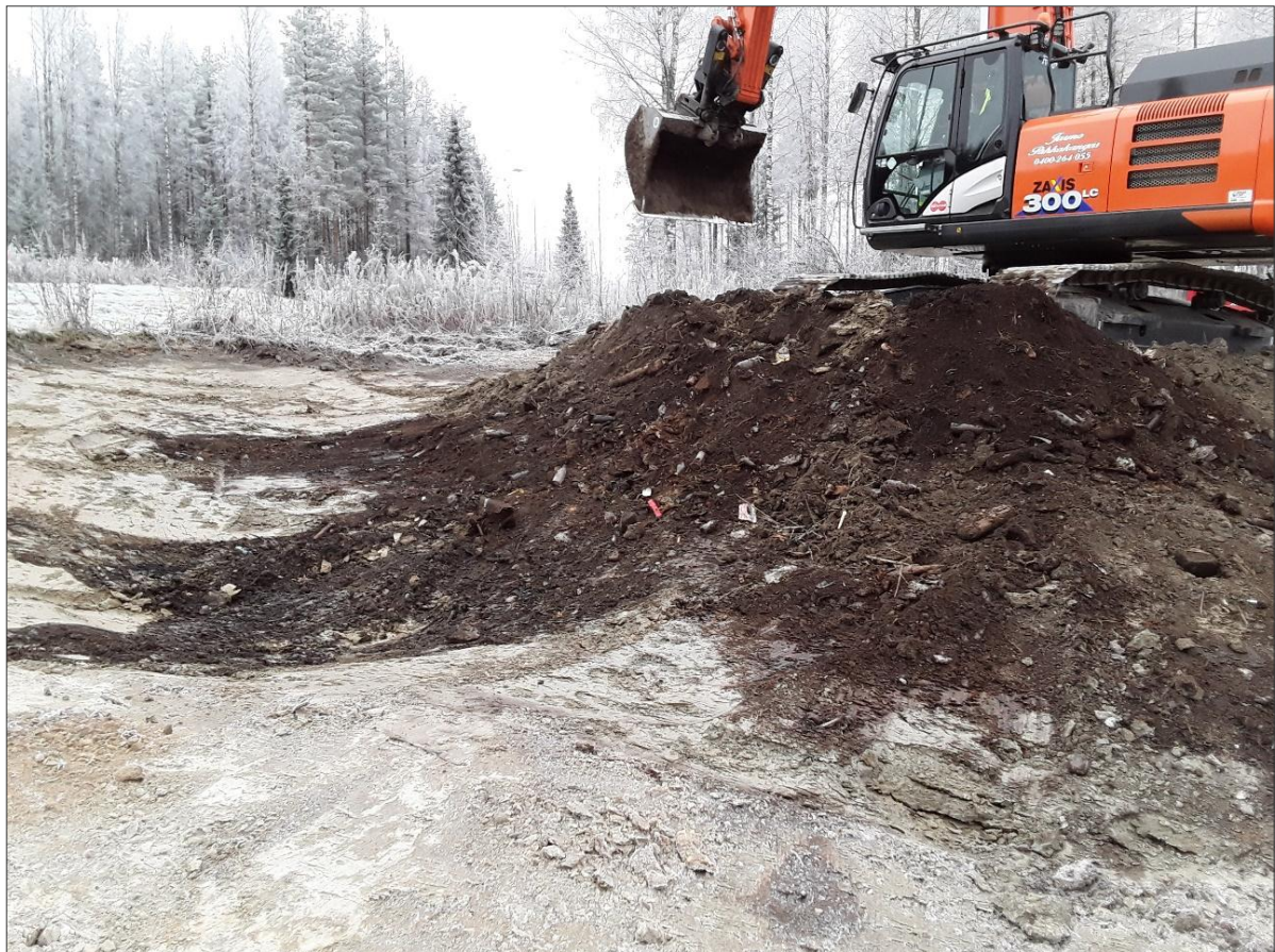
Kuva 6. Jätteitä sisältävän ja pilaantuneen maan kaivua kunnostusalueella 2. Jätteet ovat raekooltaan pieniä ja vaikea erottaa maa-aineksen joukosta.
