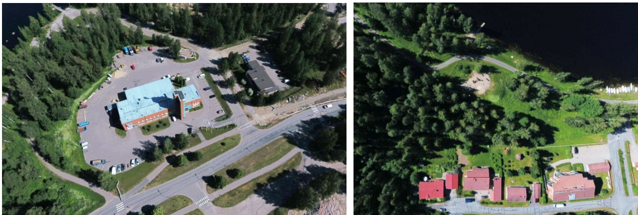
Kuva. Vasemmalla vanhan paloaseman ja eläinlääkäriaseman rakennukset ja paikoitusalueet sekä toteutettu katu- ja kevyen liikenteen verkosto. Oikealla näkyy pohjoisosasta alkavan asuinalueen rantaan toteutettua yleistä aluetta, jonne sijoittuu venevalkama ja pieni leikkikenttä.
