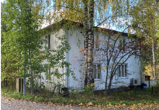
Kuva 14. Vasemmalla ylhäällä vuonna 1930 rakennettu asuinrakennus, jota on pidetty kunnossa. Vaalea lomalauta ulkoverhous ja tummat räystäät ja vuorilaudat. Oikealla ylhäällä vuonna 1936 rakennettu asuinrakennus. Kiinteistön ympäristö on hoitamaton. Alhaalla rapattupintainen noppatalo vuodelta 1938. Ympäristö on autioituneen näköistä ja rakennus on päässyt huonoon kuntoon.
