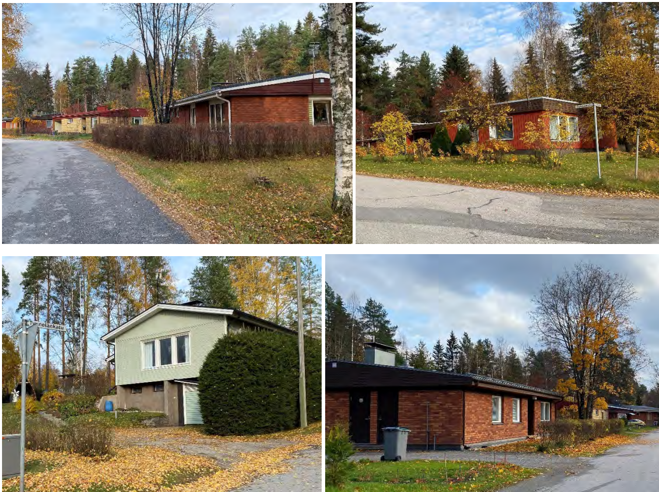
Kuva 19. Rakennuskantaa Tyynelänkadun ja Hannulantien varrella.
