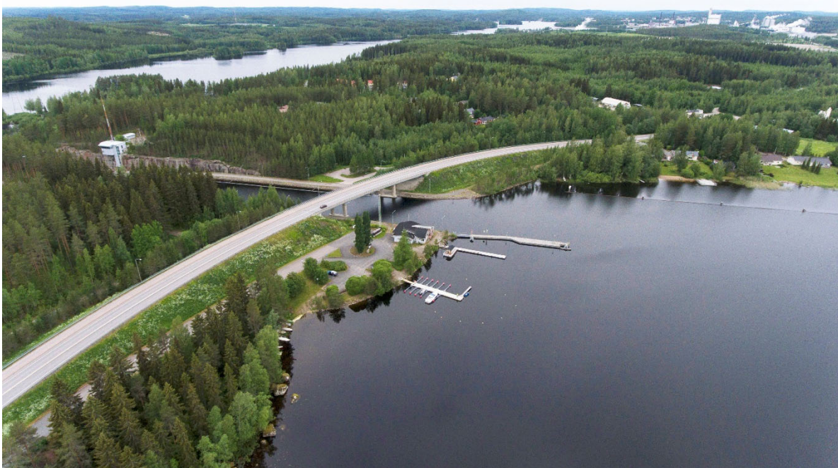
Kuva. Suunnittelualue ja sen viereinen kanava-alue. Äänekoskentie vesistösiltoineen ja vesistön kanavarakenteet luovat omanlaisensa maiseman muutoin metsäiselle alueelle. Sillalta näkymät vesistölle ovat avoimet, eikä korkeaa rakennusmassa ole näköesteenä. Alemmassa kuvassa näkyy läheiset asumisen alueet metsän keskellä sekä kaukomaisemassa Äänekosken tehdasalue.
