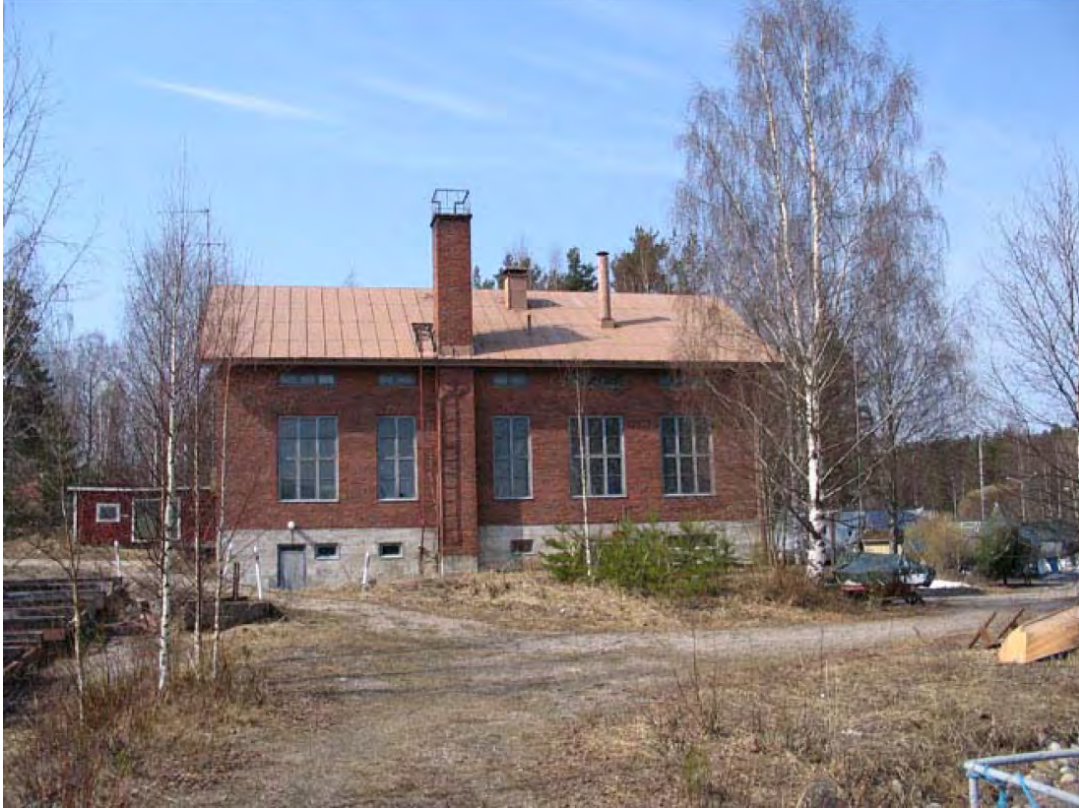
Kuva. Satamarakennus vuonna 2006 (Rakennusinventointi 2006, kohdekortti 226, Keski-Suomen museo / Juuso Väisänen, Päivi Andersson).
