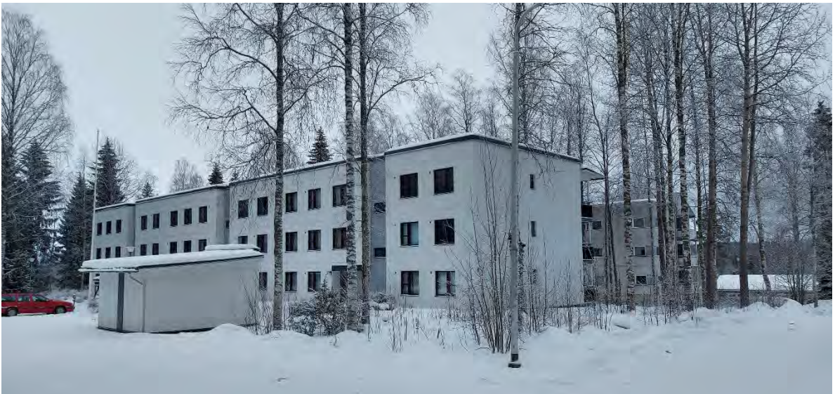
Kuva. Ylhäällä venehalli, keskellä ja alhaalla suunnittelualan kerrostaloja. Kerrostalot ovat rakentuneet 1970-, 1980- ja 1990-luvuilla ja venehalli on rakennettu 2020-luvulla.
