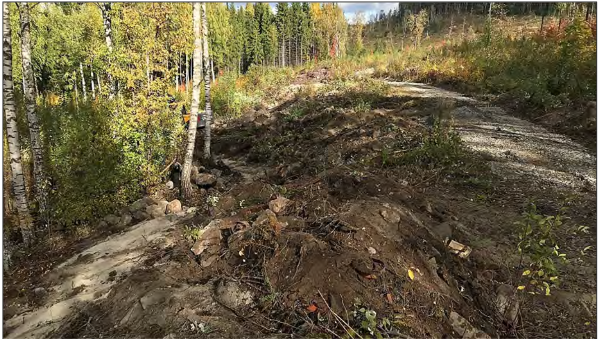
Kuva 2. Alueen 1 kunnostusvaihe, havaittua pilaantunutta maa-ainesta läjitetään aumaksi.
