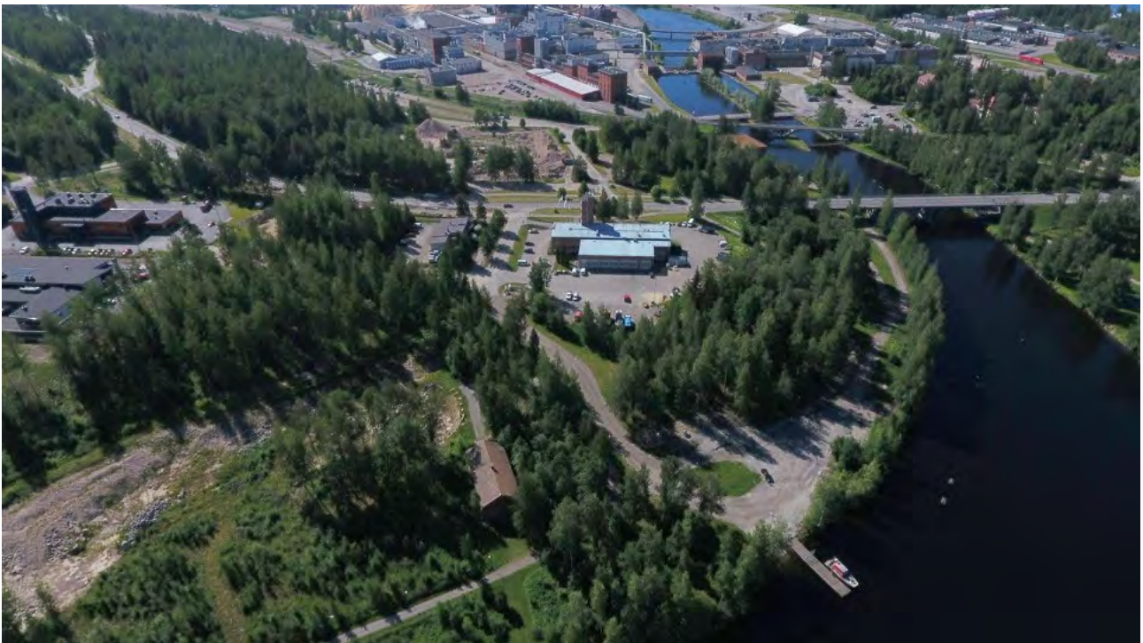
Kuva. Äänekoskentien varrelle sijoittuvat liikerakennukset sekä paloasema ja poliisiasema. Rantaan on rakennettu venelaituri, joka toimii pelastusviranomaisen käytössä. Ranta-alueelta kulkee tieyhteys teollisuusalueelle Äänekosken sillan ali. Kevyen liikenteen väylä on toteutettu sorapintaisena kulkemaan Äänejärven ranta myötäillen. Suunnittelualueelle sijoittuu (kuvassa ruskeakattoinen) vanha, alueella toimineen sahan konehuone. Rakennus toimii nykyisin varastotilana.
