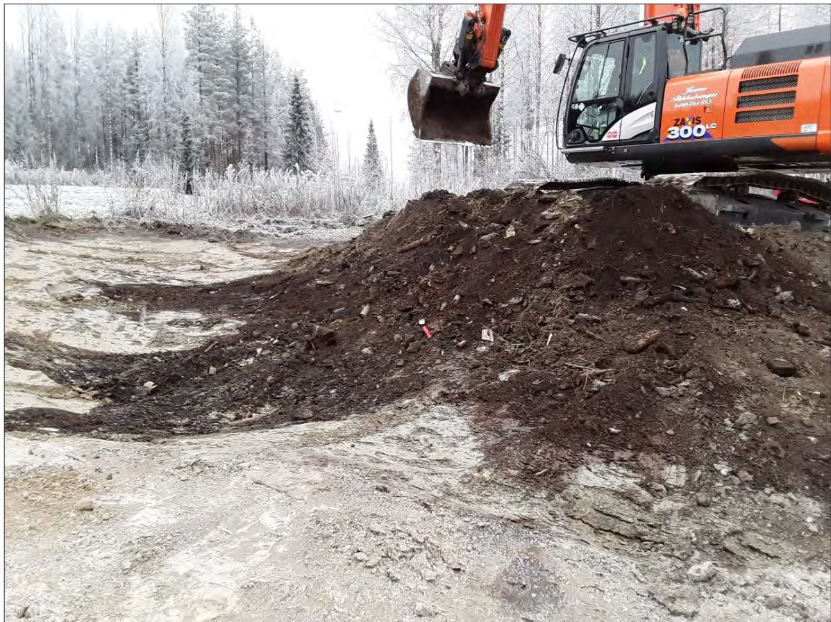
Kuva 6. Jätteitä sisältävän ja pilaantuneen maan kaivua kunnostusalueella 2. Jätteet ovat raekooltaan pieniä ja vaikea erottaa maa-aineksen joukosta.
