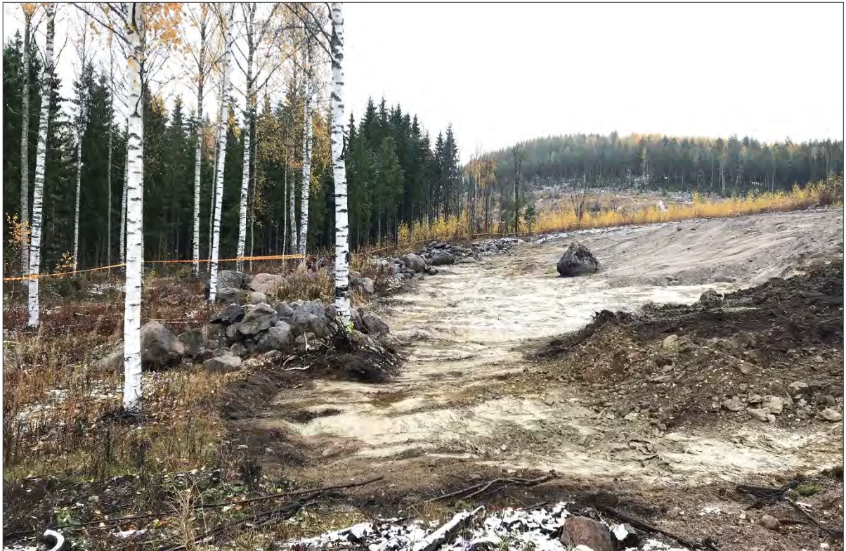
Kuva 5. Kaivualan pohjoispää kaivettuna perusmaan pintaan saakka. Maa-aineksen seasta eroteltuja kiviä näkyy kaivualan reunalla. Kuvan oikeassa laidassa näkyy tummempana poistettavaa, pilaantunutta maa-ainesta.
