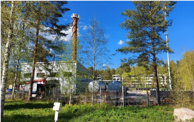
Kuva. Suunnittelualueen ulkopuolella etelässä sijaitseva lämpölaitos.
