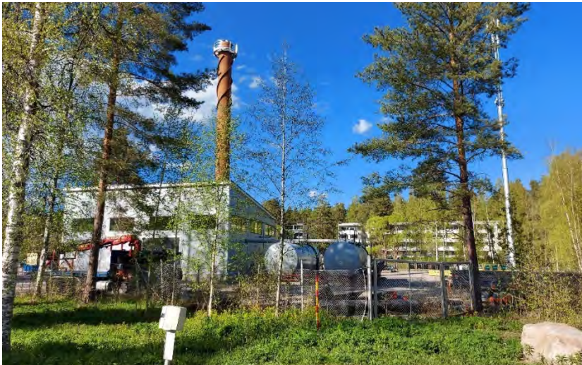
Kuva. Suunnittelualueen ulkopuolella etelässä sijaitseva lämpölaitos.
