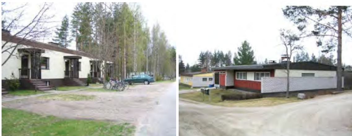
Kuvia. Markkamäen viereisen alueen rakennuskantaa (Rakennetun ympäristön inventointi, Markkamäki, Mustikkasuonkadun ja Niinimäenkadun asemakaavan muutos, Tuuli Tolonen 2005).
