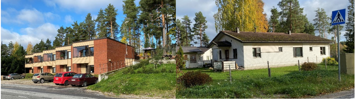
Kuva 20. Vasemmalla vuonna 1981 rakentunut punatiilinen ja tasakattoinen rivitalo. Oikealla vuonna 1989 rakentunut harjakattoinen valkotiilirakennus. Rakennukset ovat hyväkuntoisia.
