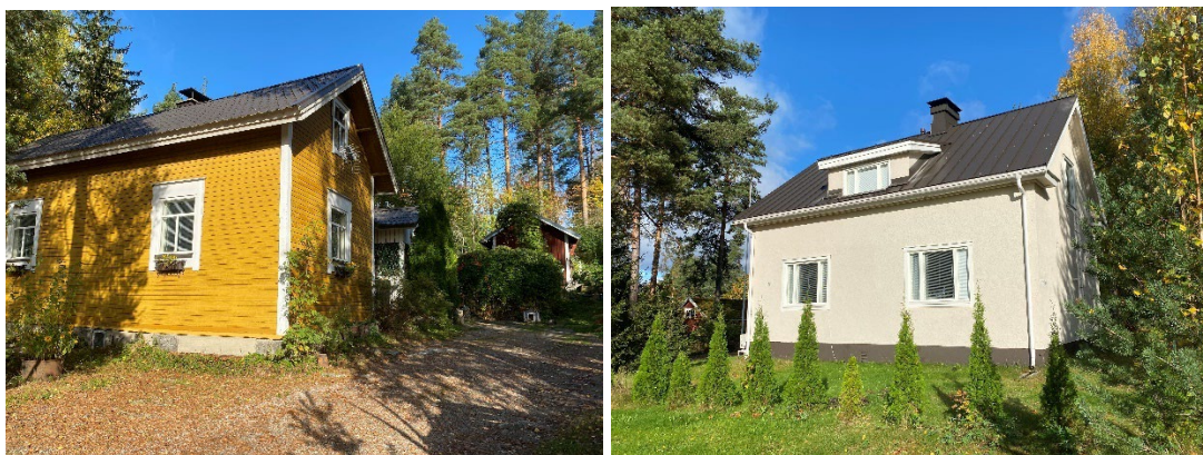
Kuva 13. Vasemmalla vuonna 1928 rakennettu asuinrakennus, jota on pidetty kunnossa. Oikealla Helinin talo vuodelta 1934. Talon julkisivu on pidetty kunnossa.
