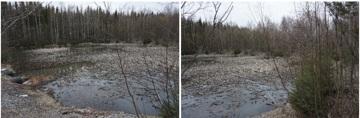
Kuva 6. Hirvaskankaan alueelle rakentunut hulevesiallas.
