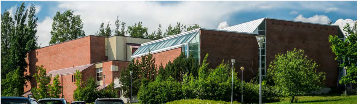
Kuva 7. Liikuntatalo ja uimahalli. Punatiilinen liikuntatalo rakennettiin alun perin palvelemaan oppilaita, koska koulurakennuksista puuttuivat kunnolliset liikuntatilat. Liikuntatalon suunnitteli arkkitehti Jorma Vesanen. Uuden vuosikymmenen arkkitehtuurityyliä ennakoanut punatiilivuorattu liikuntarakennus valmistui vuonna 1981.
