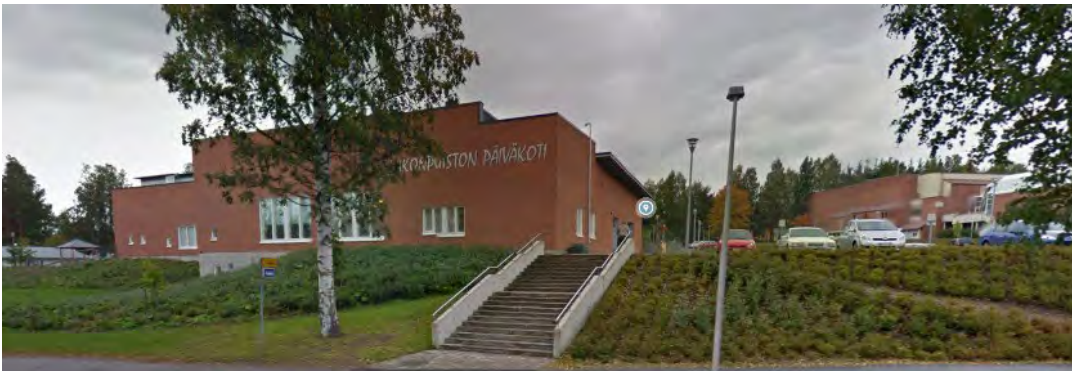
Kuva 8. Mikon päiväkoti (Kuva Googlemaps.fi, 9/2011). Portaat alueelle Mämmensalmentien puolelta.
