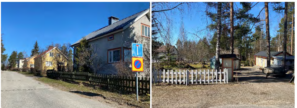
Kuva 14. Louhenkadun varren rakennuskantaa.
