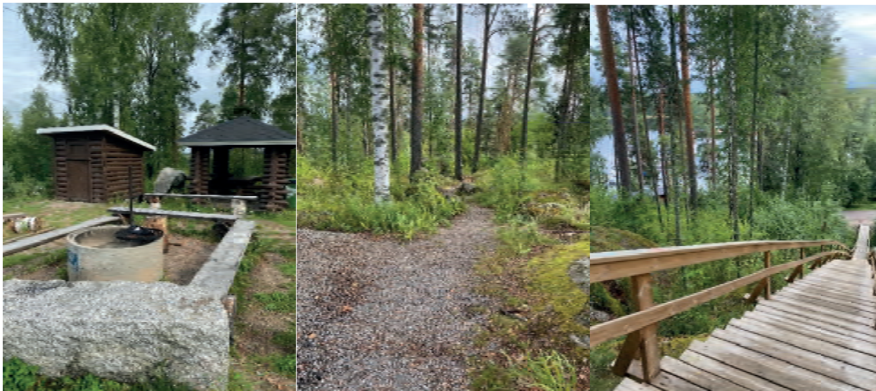
Kuva 12. Kuvissa vasemmalla Kukkulanpuiston alueelle toteutettu tulipaikka ja puuvarasto. Keskimmäisessä kuvassa sorapolku johtaa rakennettujen kuntoportaiden yläpään.
