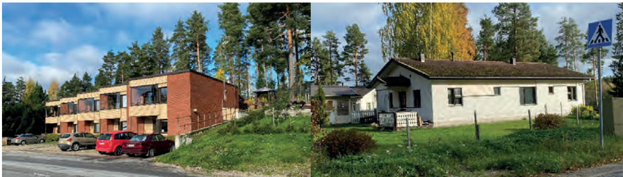
Kuva 20. Vasemmalla vuonna 1981 rakentunut punatiilinen ja tasakattoinen rivitalo. Oikealla vuonna 1989 rakentunut harjakattoinen valkotiilirakennus. Rakennukset ovat hyväkuntoisia.
