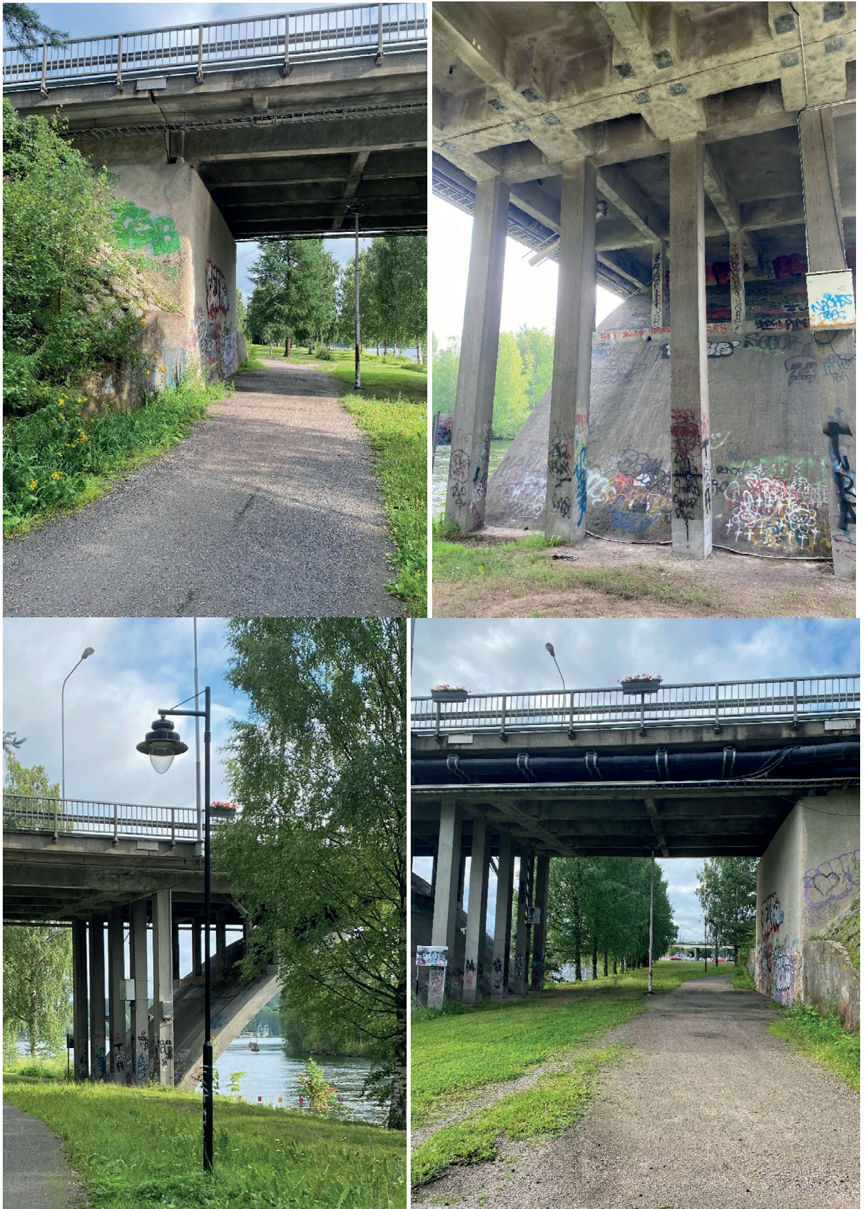
Kuvat. Siltarakenteita purettavasta Äänekosken sillasta etelän suunnasta kuvattuna. Alhaalla oikealla kuva pohjoisesta etelänsuuntaan kuvattuna. Valaistu sorapintainen kevyen liikenteen väylä kulkee Äänekoskentien ali vesistön ranta-alueella. Kevyen liikenteen väylän ja vesistön välinen viheralue pidetään hoidettuna.
