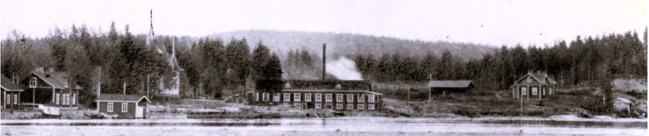
Kuva 5. Ali Riihijärven saha vuonna 1911. Vasemmalla Mäntyniemen rakennuksia: Leipomo, venekoppi ja puiden takana päärakennus, jonka väritys ja muoto oli muuttunut vuodesta 1906: rakennus on vaaleampi, ja siihen rakennettiin tähtitorni. Keskellä kuvaa on saha piippuineen, ja oikealla oleva talo on Kankaisen talo. Kuva: Vanhan Äänekosken Kotiseutuyhdistyksen valokuva-arkisto
