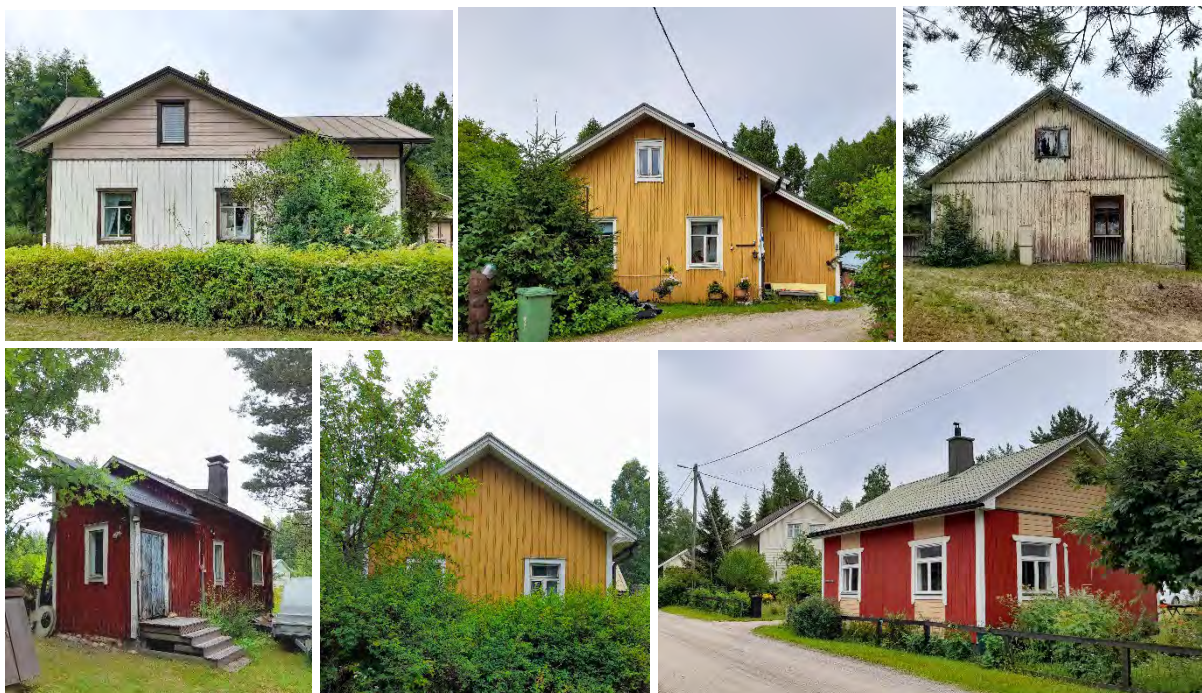
Kuva 20. Höökinkadun harjakattoisia rakennuksia 1900-luvun alkuvuosikymmeniltä.
