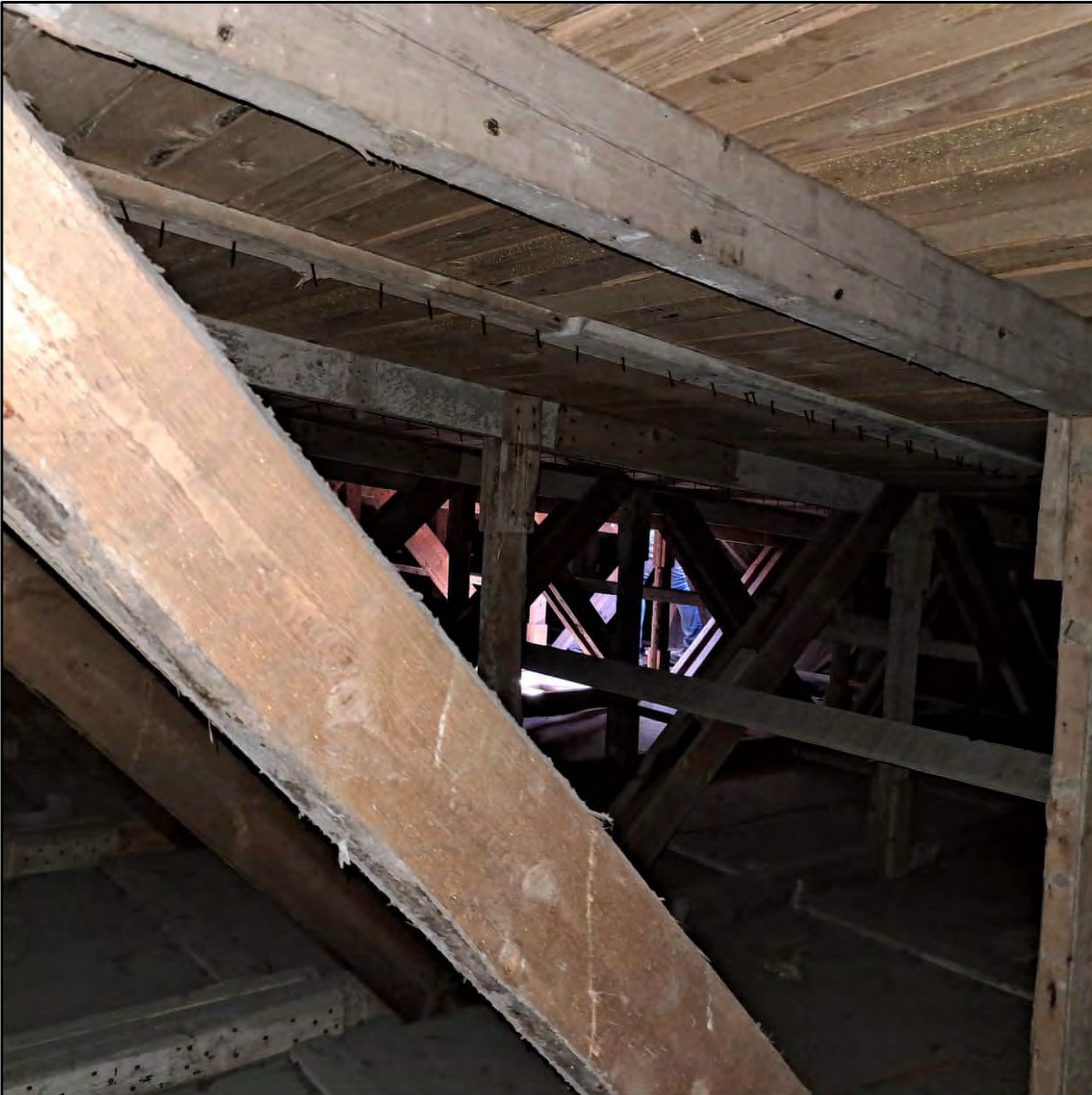
Kuva 71. Vanhan työterveystalon välikattoa tilavammalla talon pohjoisosassa. Kuvan taka-alalla näkyvä valo tulee auki olevasta kattoluukusta, josta katolle kuljetaan.
