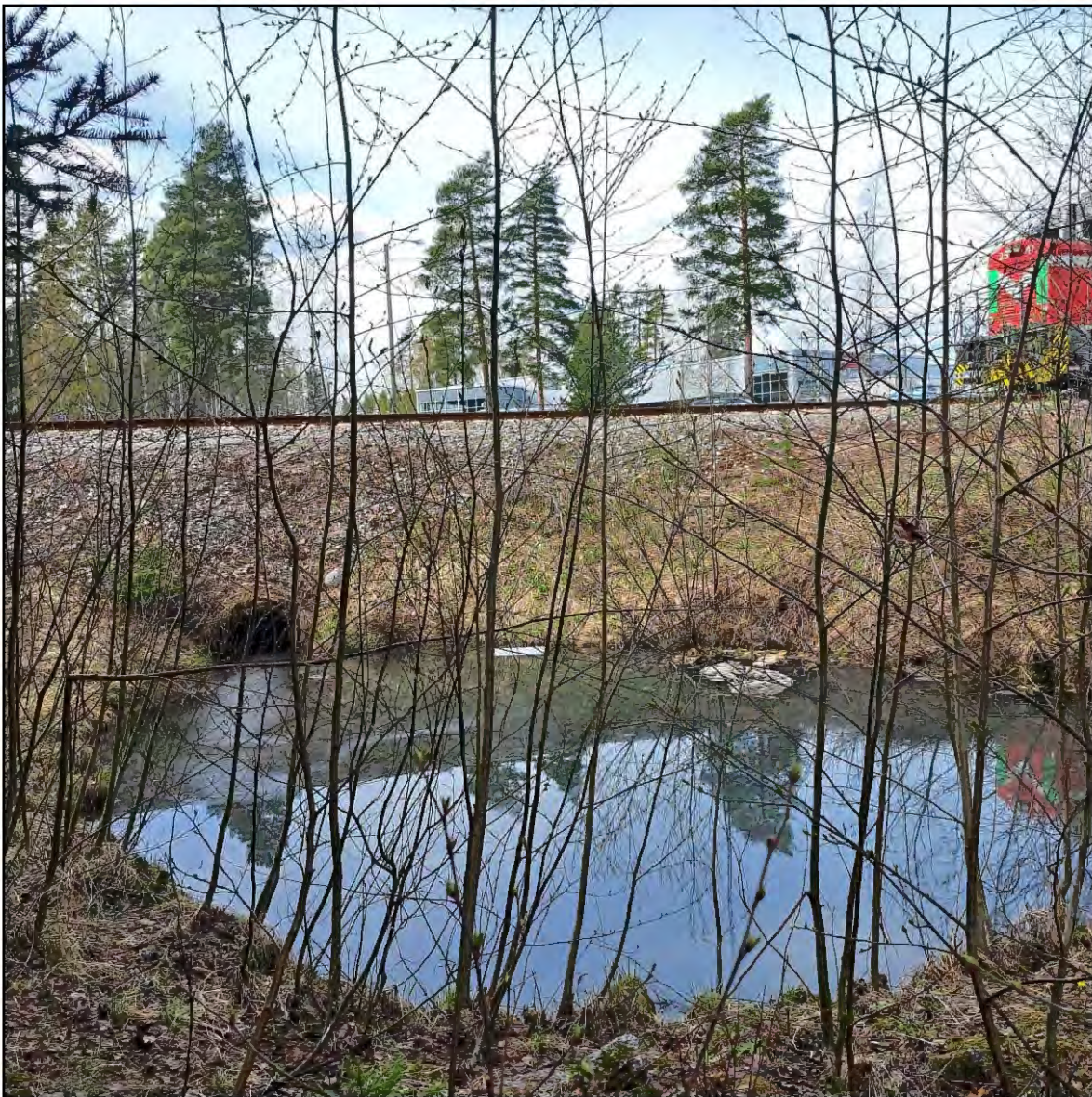
Kuva 68. Kohteelle 6.3. Natura-alueelle Pienen Sirkkalammen rantasuolle lasketaan Valtran tehdasalueen hulevesiä radan ali radan ja kantatien 69 risteyskohdan eteläpuolelta. Kuvaussuunta länsiluoteeseen.
