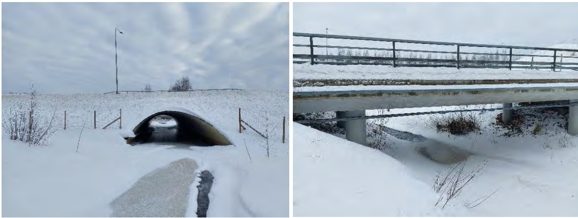
Kuva 9-4. Valtatie 4 allittava rumputunneli tien länsipuolelta kuvattuna (vas) ja Rannankyläntien sillan allittava osuus Kuorejoesta (oik).
