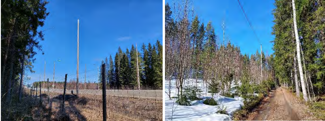
Kuva 6-10. Puustoinen yhteys valtatie 4 ylitse Kylmähaudasta itään (vas) ja länteen (oik). Vasemmassa kuvassa näkyvät myös puiset hyppy- ja valotolpat.
