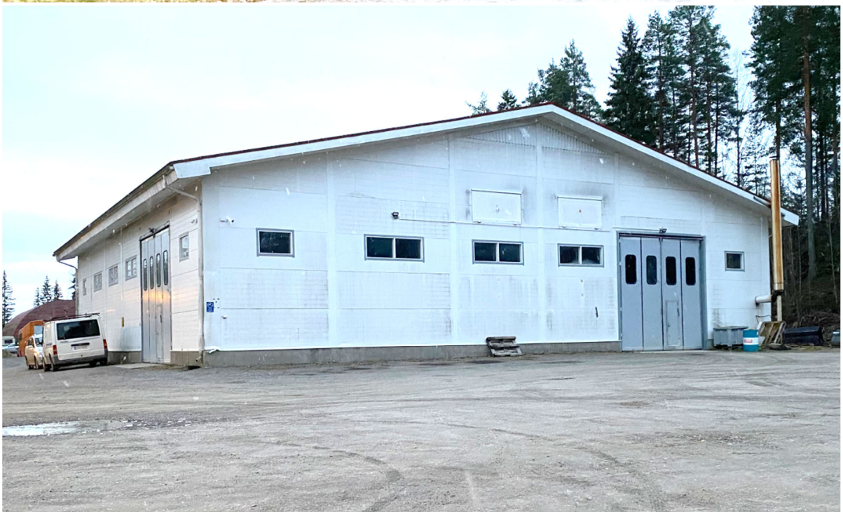
Kuvia. Teollisuuskadun varrelle toteutettua rakennuskantaa. Alueella on neljä varstorakennusta/hallia.
