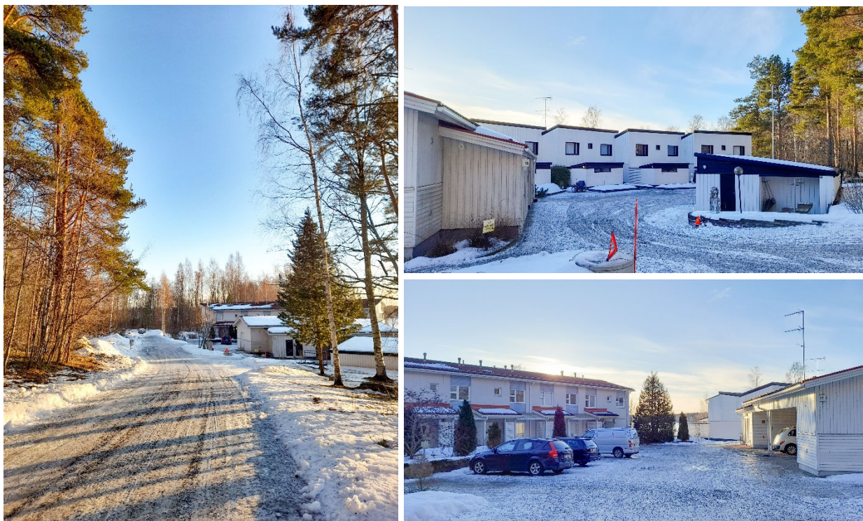
Kuva 17. Lönnrotin kadun loppupäässä on viuhkamaisia kaksikerroksisia rivitaloja.
