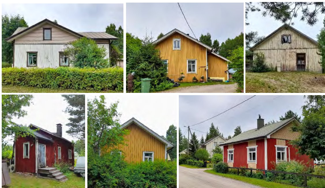
Kuva 25. Höökinkadun harjakattoisia rakennuksia 1900-luvun alkuvuosikymmeniltä.
