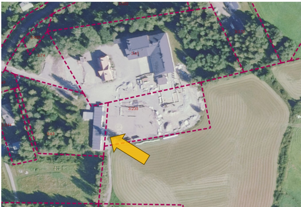
Kuva 26. Ilmakuva suunnittelualueelta. Parakkien jättämän nykyisen aukean sijainti on soitettu nuolella.
