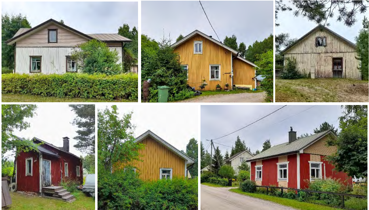
Kuva 25. Höökinkadun harjakattoisia rakennuksia 1900-luvun alkuvuosikymmeniltä.
