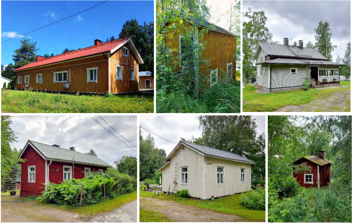
Kuva 19. Majalankadun vanhimpia rakennuksia 1900-luvun alkuvuosikymmeniltä. Ylhäällä vasemmalla entinen sahan vuokra-asuintalo Mäkinen, jonka vieressä vanha rantaan rakennettu puusepänverstas. Harmaa "Kankaisten talo" on yksi rungoltaan vanhimmista asuinrakennuksista. Alla asuinrakennuksia ja saunamökki.
