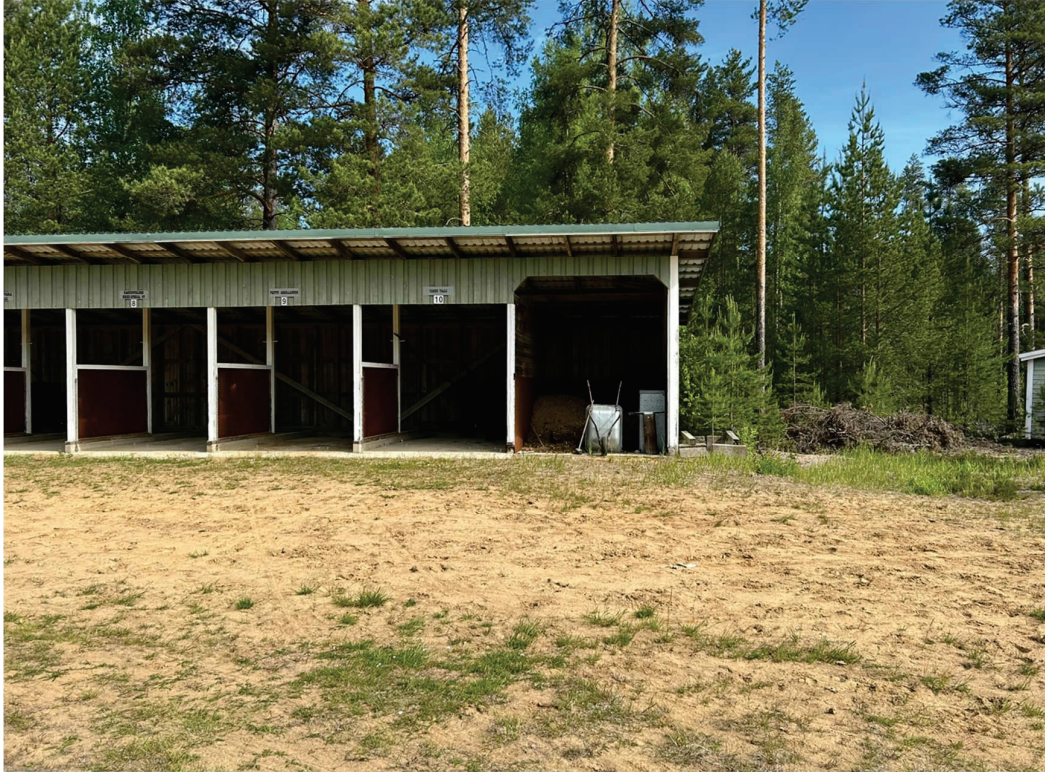
Kuva 13. Raviradan lantala on siisti, suojassa ja päällystetyllä alueella.
