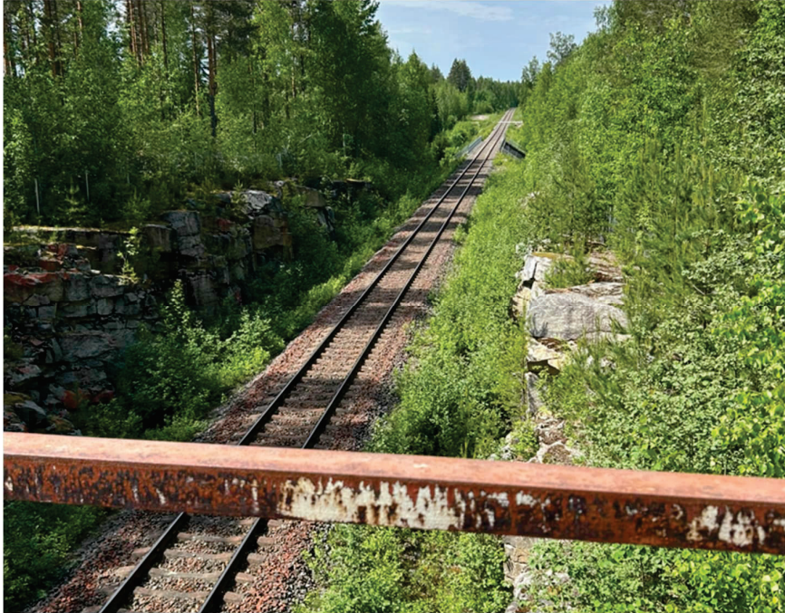
Kuva 25. Yleiskuva pohjavesialueella kulkevasta junaradasta.
