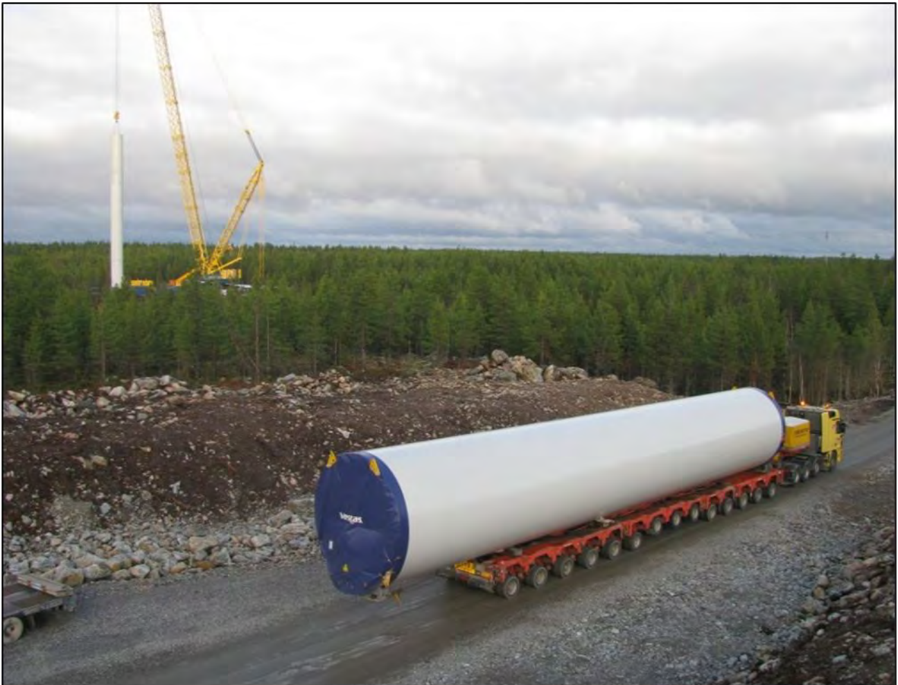
Kuva 23. Voimalat kuljetetaan rakentamisaikalle osissa (Myrsky Energia Oy)
