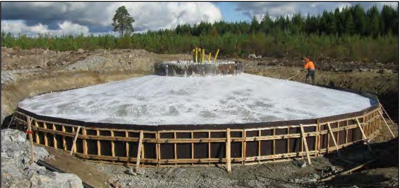
Kuva 11. Esimerkkikuva tuulivoimalan maavaraisesta perustuksesta valun jälkeen (Myrsky Energia Oy)
