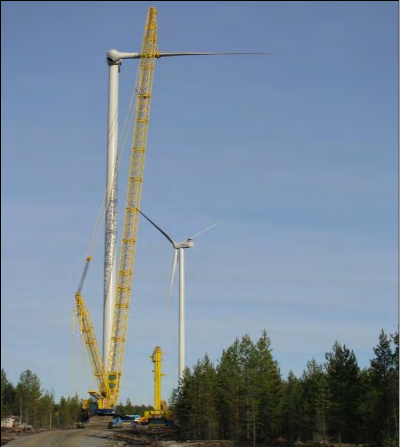
Kuva 24. Tuulivoimalat kootaan valmiiksi rakentamisaikalla (Myrsky Energia Oy)
