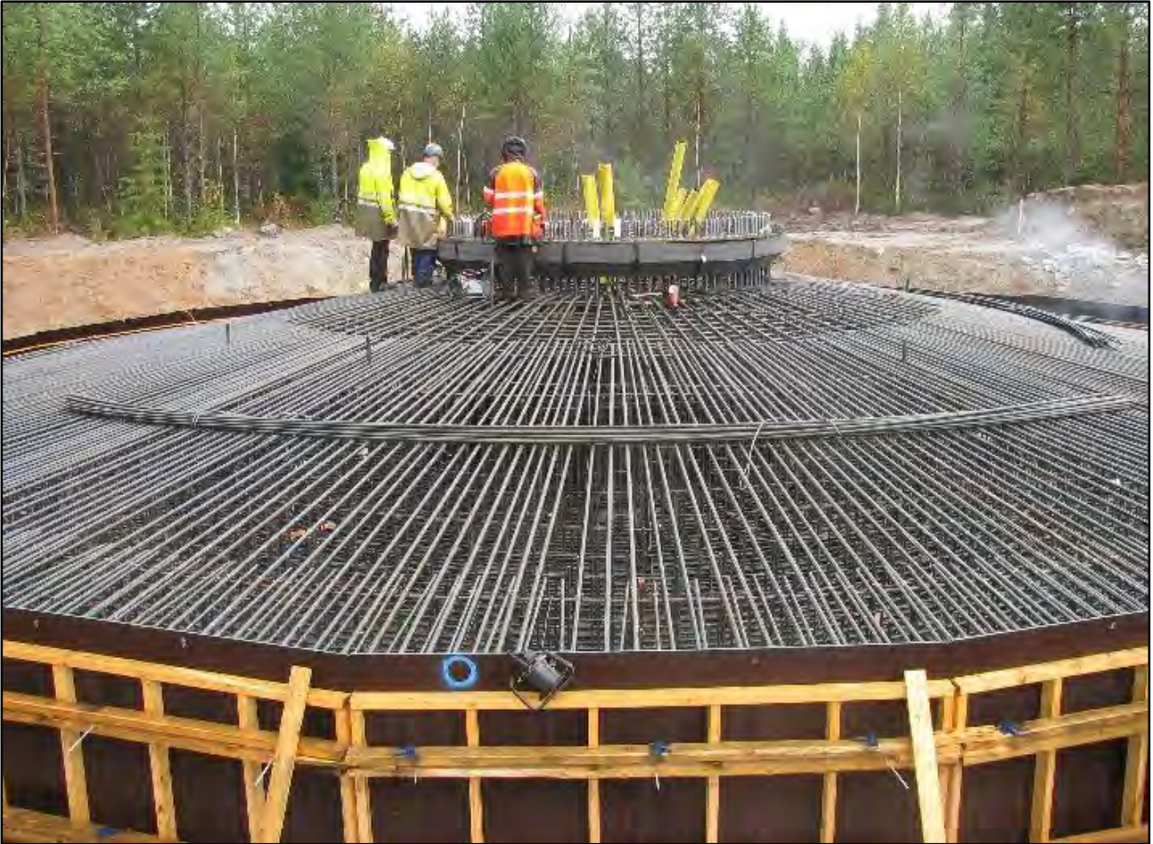
Kuva 10. Esimerkkikuva tuulivoimalan maavaraisesta perustuksesta ennen valua (Myrsky Energia Oy)
