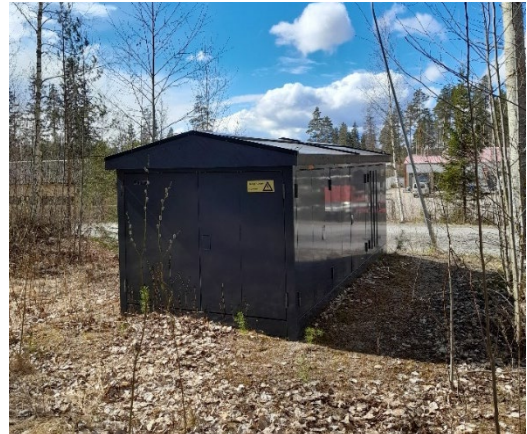
Kuva 21. Kuvassa KTY-tontille sijoittuva jätevedenpumppaamo.
