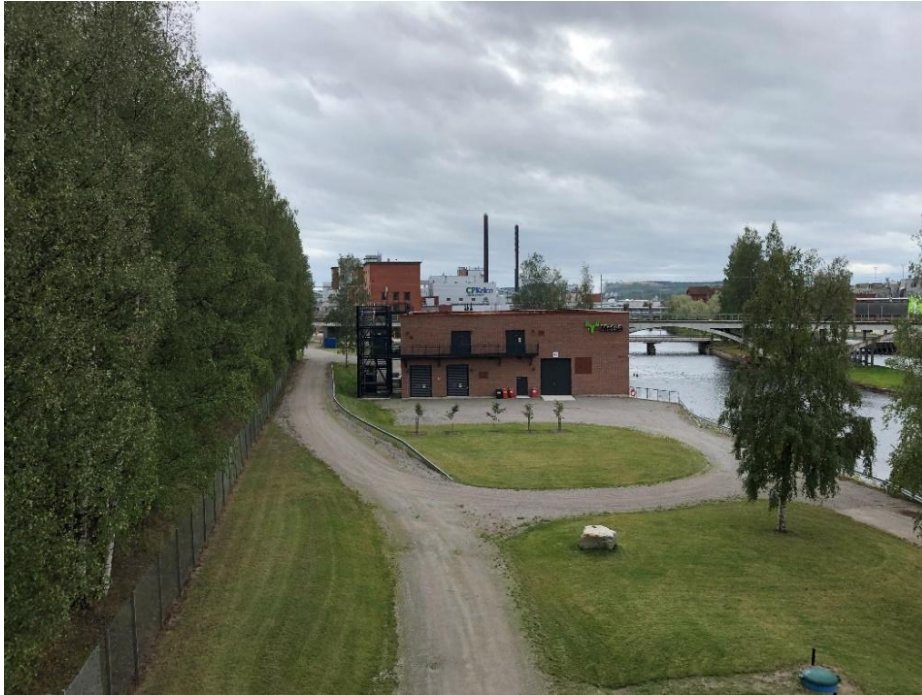
Kuva 16. Valokuva biotuotetehtaan raakavedenottamosta Äänejärven rannalla.
